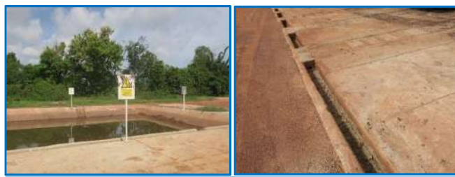
รางระบายน้ำและบ่อคอนกรีตเก็บน้ำ (Concrete Pit)
